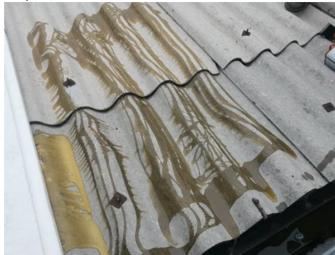
Colle Sika® Trocal C-300 déposée sur le support
